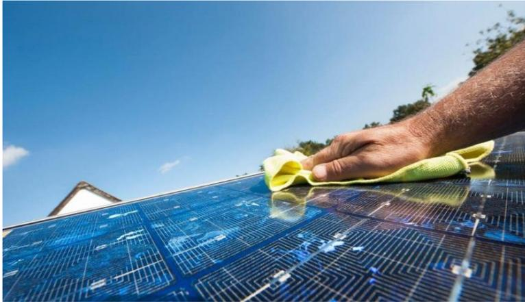
En el caso de que tengas los paneles fotovoltaicos instalados sobre el terreno, no merece la pena contratar los servicios de un profesional de limpieza, **ya que tú mismo puedes limpiar.**
